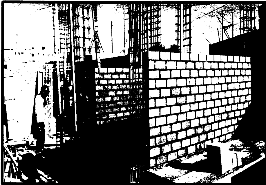
FOTOGRAFIA 03: Asentado de muros en área de Administración.
