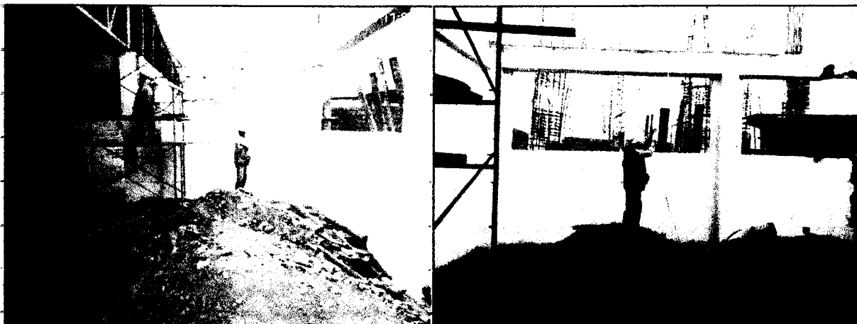
Foto N° 19 y 20: vista de la ausencia de la demolición total de muros y vigas existente al 01 de junio del 2019.
