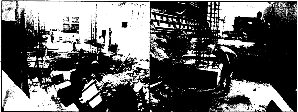
Foto N° 13 y 14: vaciado de zapatas del Bloque de Administracion.
